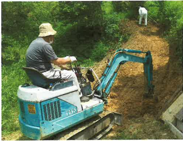
歩道改善作業指導中
