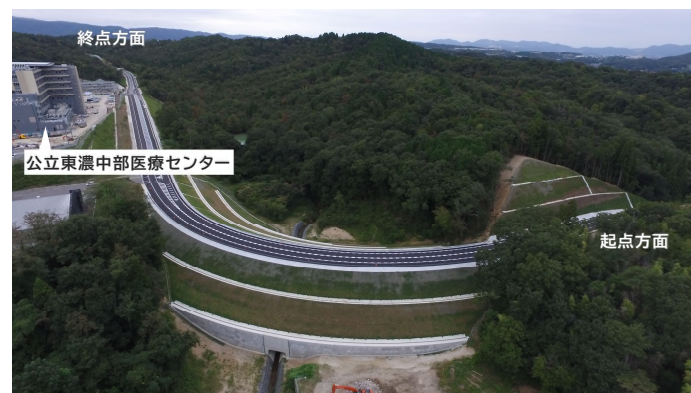
公立東濃中部医療センター付近(起点側から撮影)
