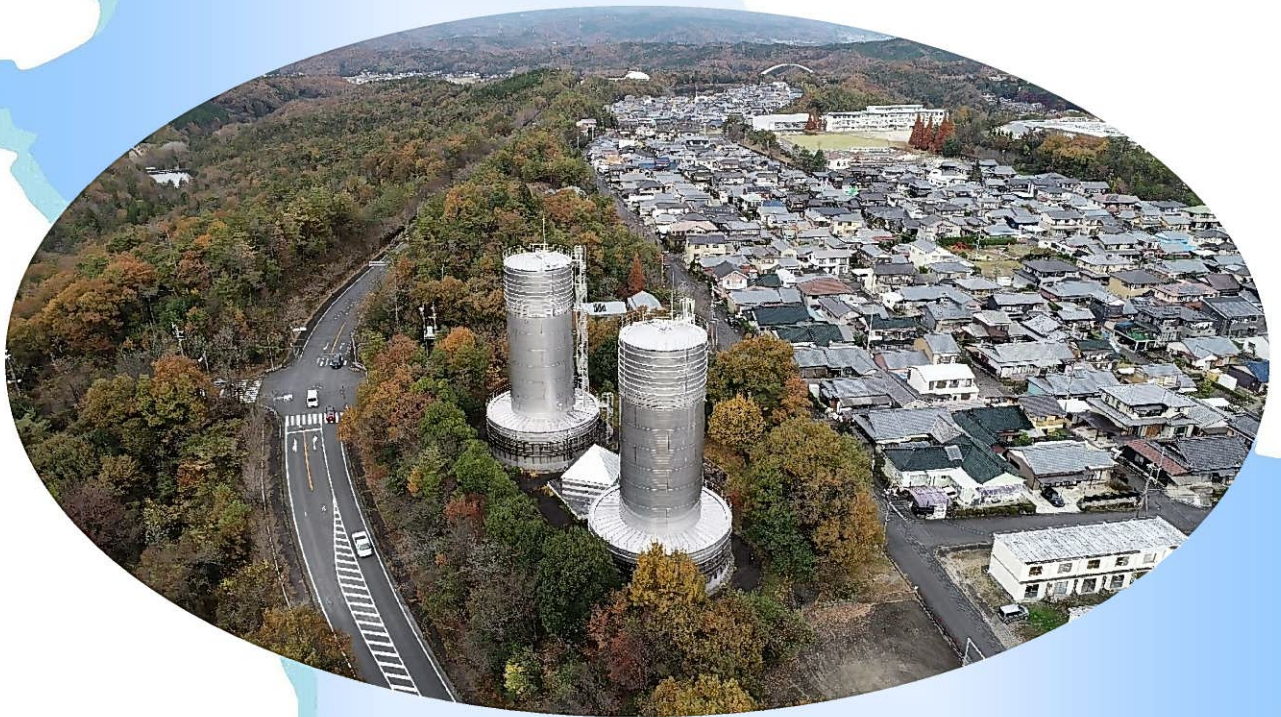
(写真：旭ヶ丘配水池)
