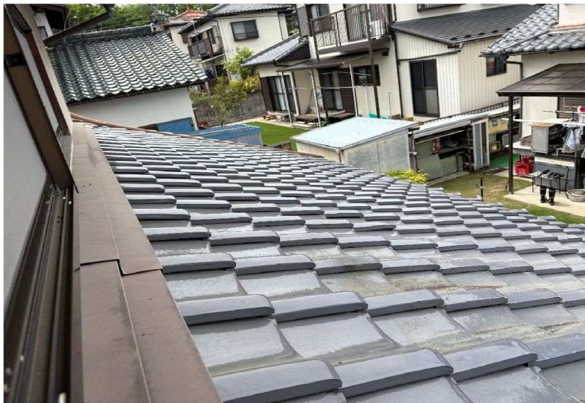
No.8 外観:北側1階屋根
