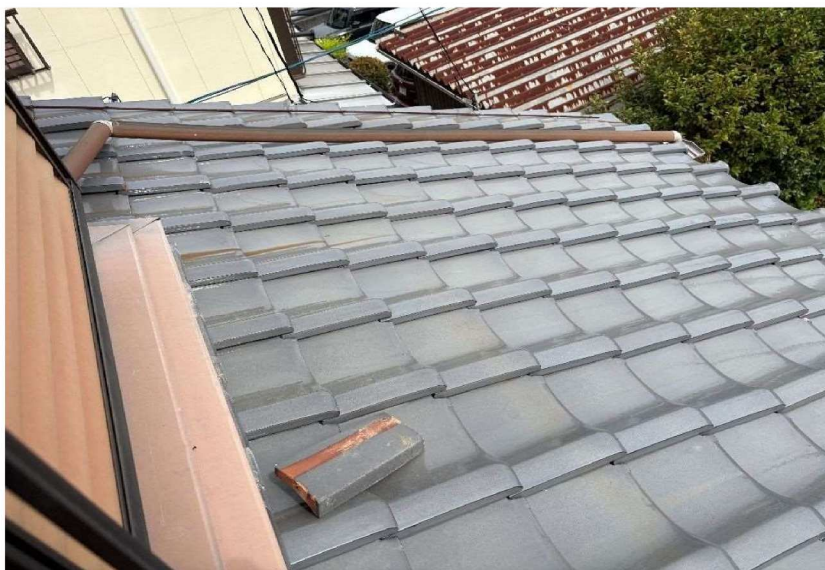
No.9 外観:南側1階屋根
