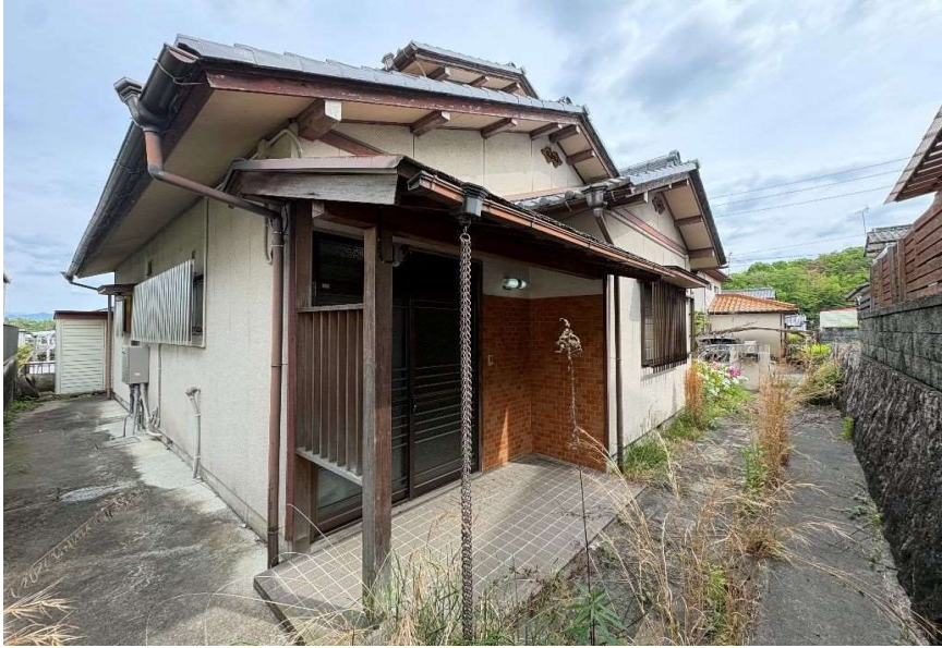
No.4 外観:北東側
