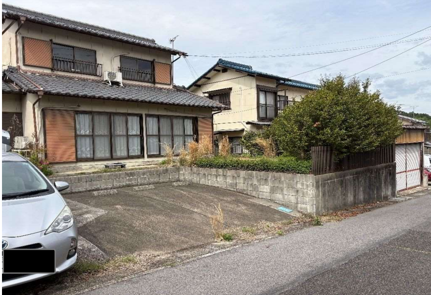
No.1外観:南側
