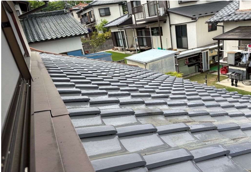
No.8 外観:北側1階屋根
