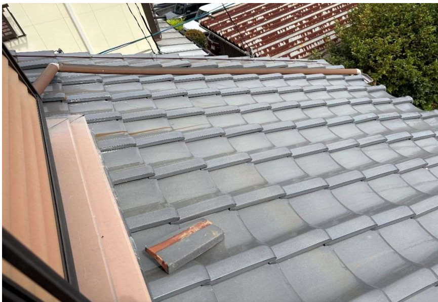
No.9 外観:南側1階屋根
