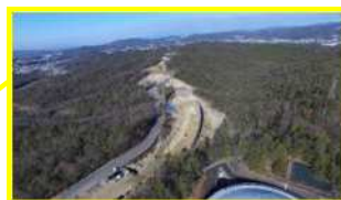
工事進捗(令和5年12月)
