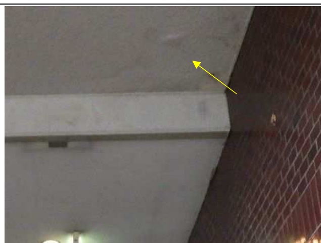
(東階段)天井：モルタル+吹付
