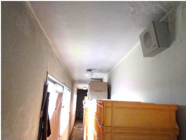
天井：モルタル+塗装、壁：モルタル+塗装
