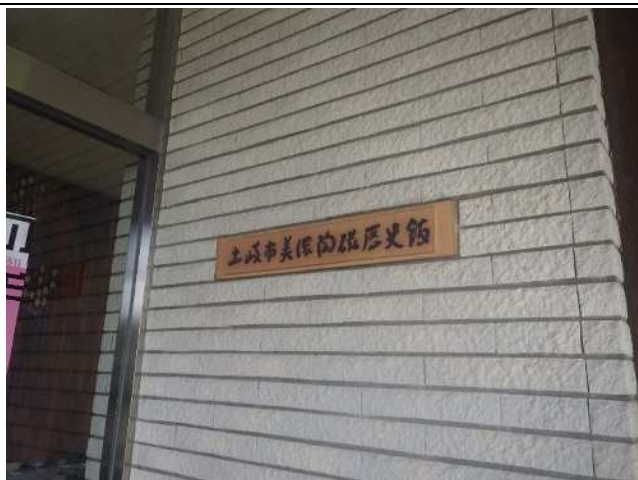
玄関外壁：煉瓦タイル+下地調整材
