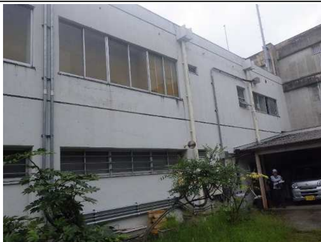
外壁：打放し+吹付
