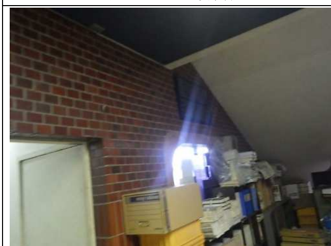
(東階段)壁：タイル+下地調整材
