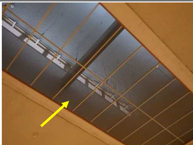
天井(CH4950～)：PB+吹付タイル
