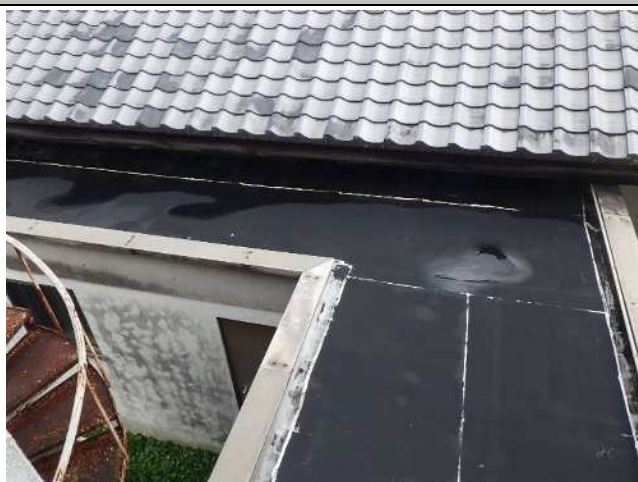
廊下屋根：シート防水
