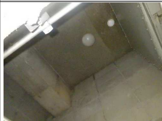
天井：木毛板、壁：打放し・CB積み
