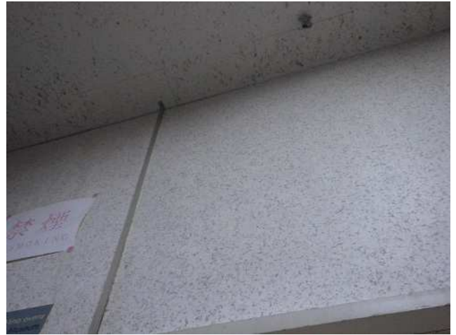
壁：ゾラコート吹付
