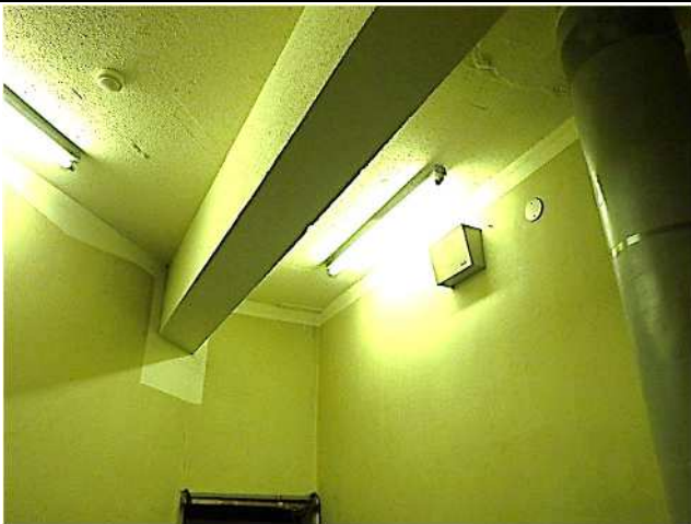
天井：打放し+ゾノライト吹付、 壁：モルタル+塗装
