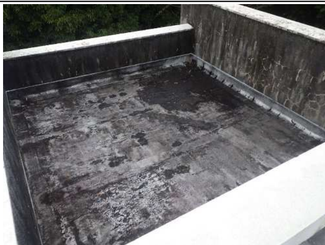
屋根：シート防水
