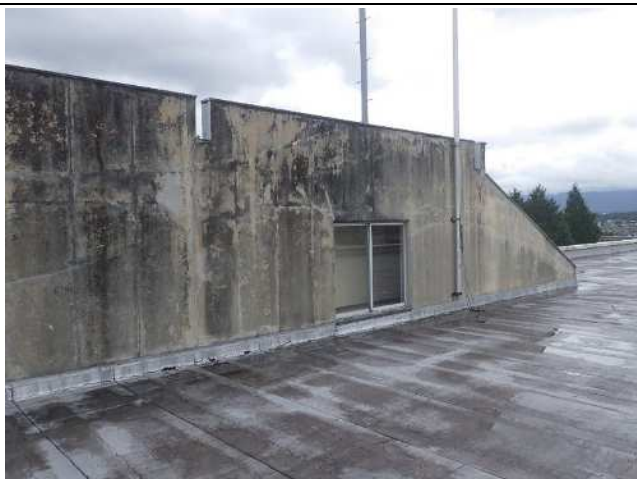
塔屋外壁：打放し+吹付
