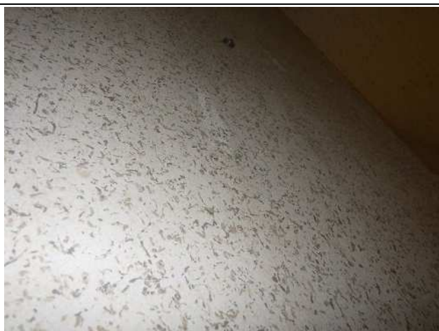
壁：モルタル+ゾラコート吹付②
