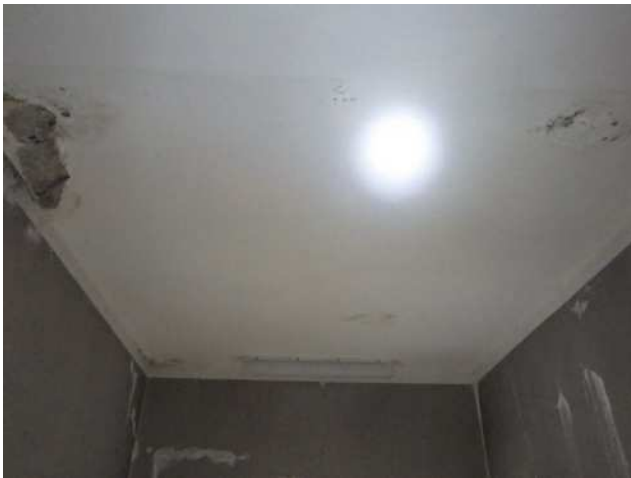
天井：吹付、壁：モルタル+吹付
