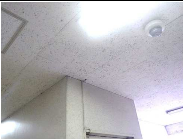
天井：岩綿吸音板+PB
