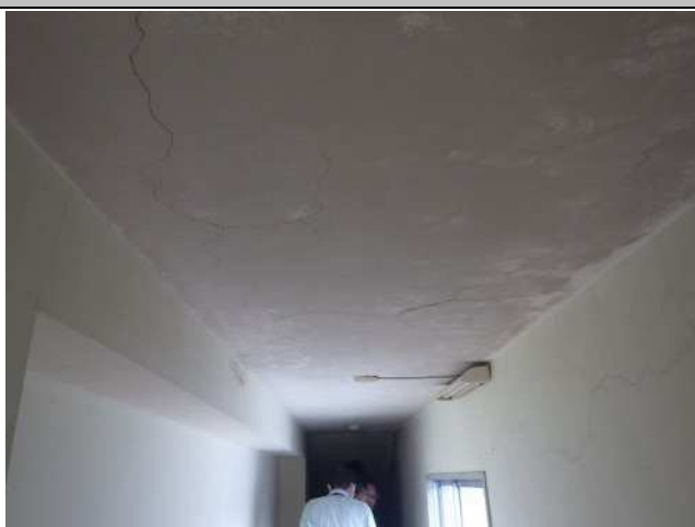
天井：モルタル+塗装、壁：モルタル+塗装
