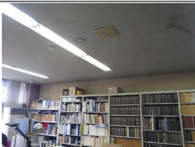
天井：ボード+クロス、壁：モルタル+クロス
