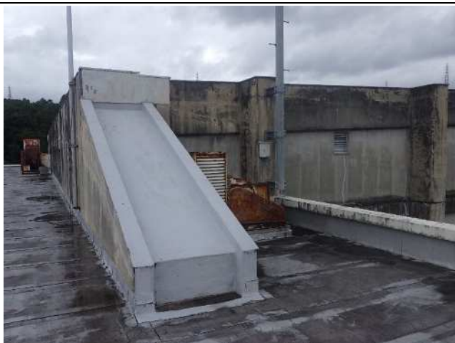
屋根：ウレタン防水
