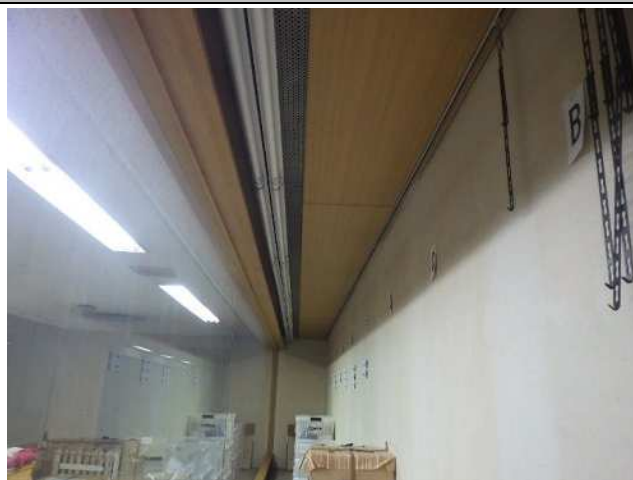
(展示内)天井：木目ボード、壁：ボード+吹付
