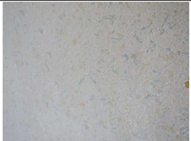
壁：モルタル+吹付
