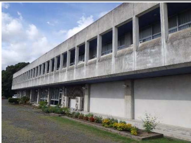
外壁：打放し+リシン吹付
