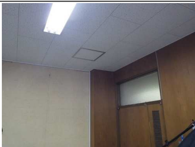
天井：ジプトーン、壁：モルタル+クロス
