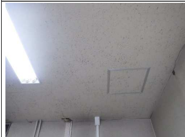
天井：岩綿吸音板+PB
