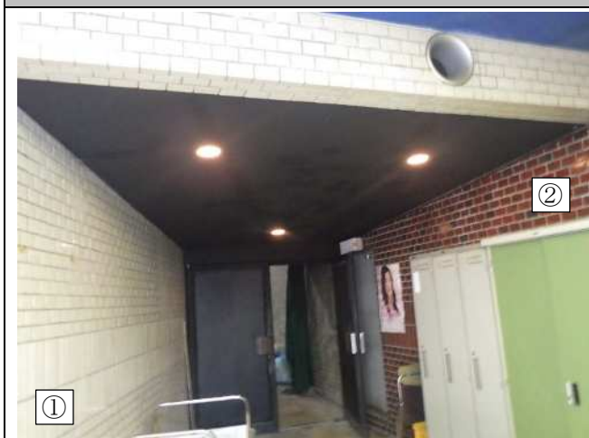
天井：吹付(黒)、壁：タイル+下地調整材①②
