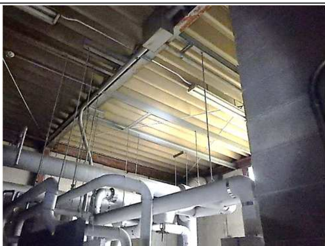
機械室屋根：折板屋根+断熱材
