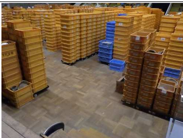
床：ナラフローリングブロック+接着剤
