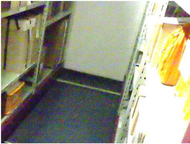
巾木：モルタル+塗装
