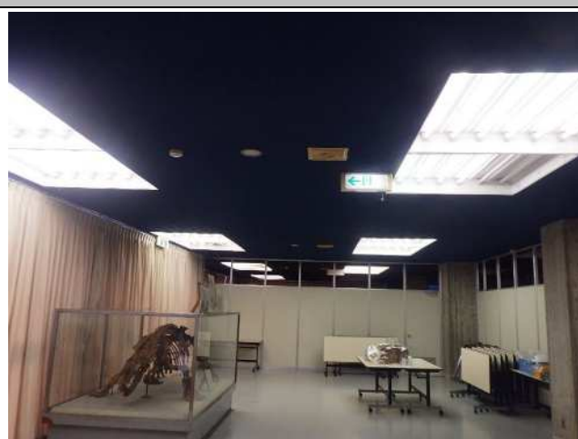
天井：ボード+吹付(青)、床：長尺シート+接着剤
