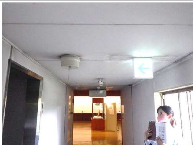
天井：ボード+塗装、壁：モルタル+塗装
