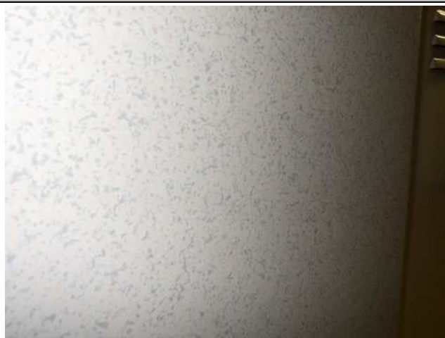
壁：モルタル+ゾラコート吹付①
