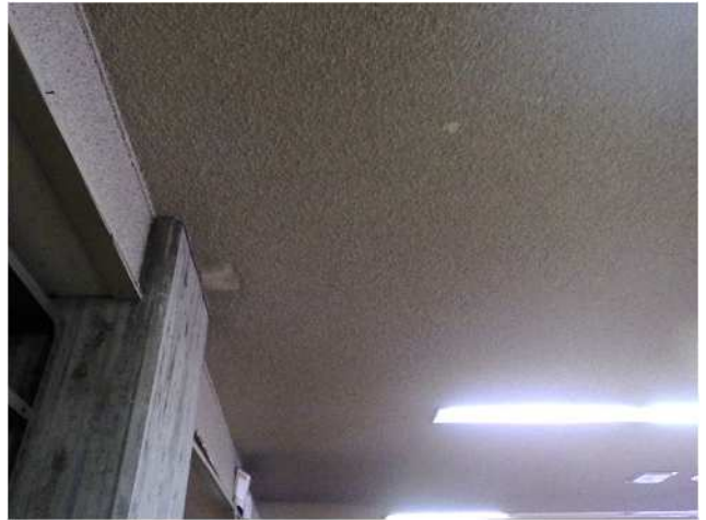
天井：ボード+吹付
