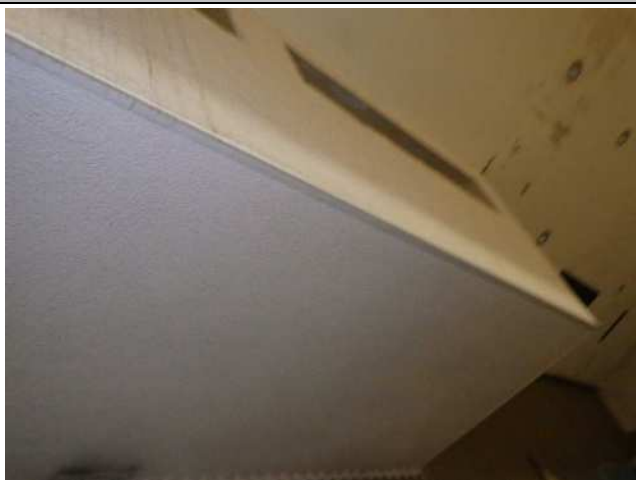
壁：ボード+吹付・フレキシブルボード
