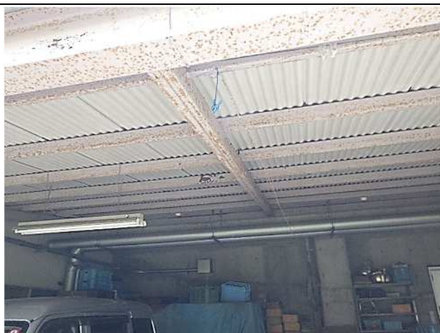
上屋屋根：スレート
