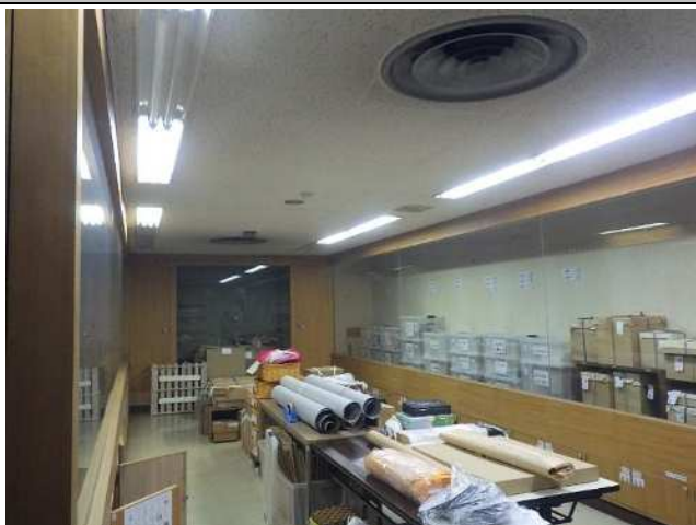
天井：岩綿吸音板+PB
