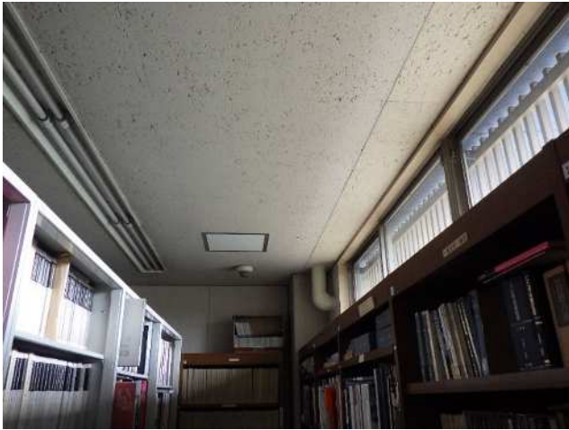
天井：岩綿吸音板+PB
