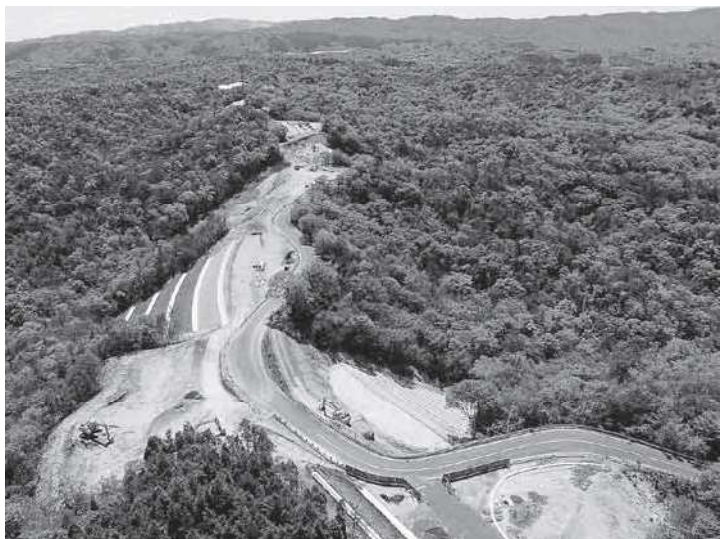
陶元浅野線道路新設工事現場▶
