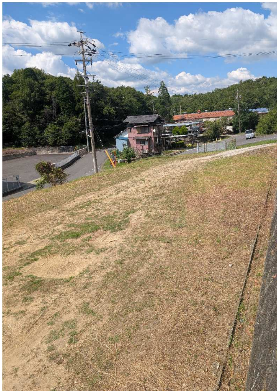
南西方向から撮影
