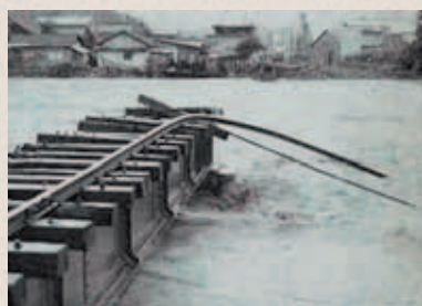
四七災害で流された土岐川の鉄橋 (広報とき 47.7豪雨増大号より)
