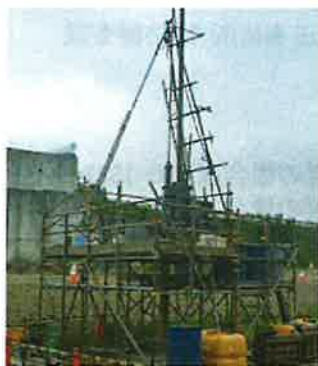
写真① 地質調査機械設置状況
