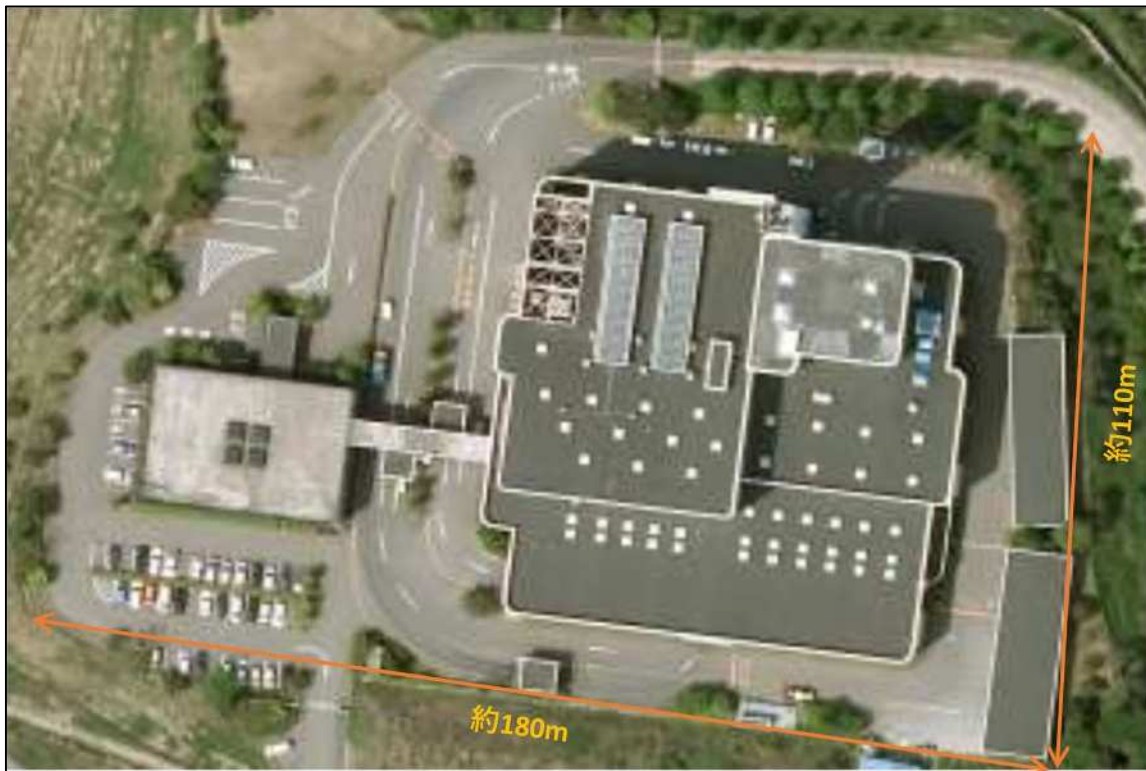
写真 1 福井坂井地区広域市町村圏事務組合清掃センター
