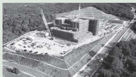
建設中の新病院 （令和7年5月31日時点）
