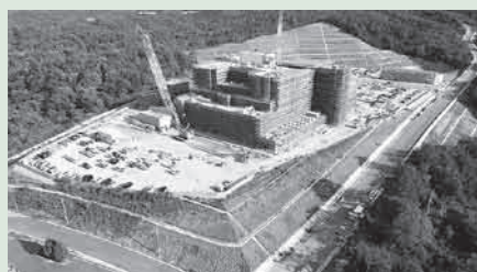
建設中の新病院 （令和7年5月31日時点）
