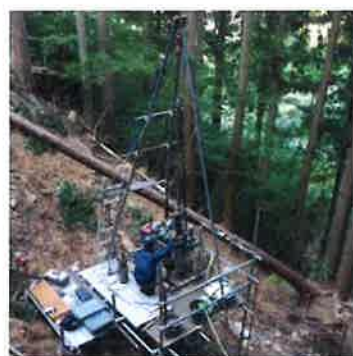
ボーリング調査
