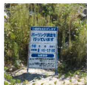
ボーリング作業
