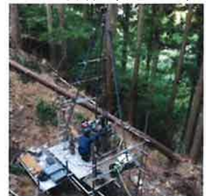
ボーリング作業（イメージ）
