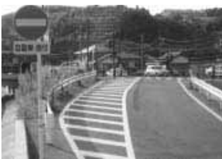
永久橋北詰堤防道路
