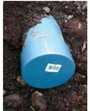
▲取付管にキャップをして閉栓
