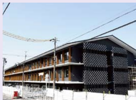
▲新庁舎建設現場
