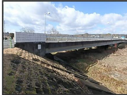
新土岐川橋（橋長 158.9m） 平成元年生まれ、現在 30 歳
