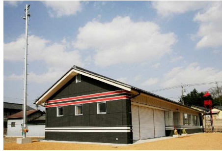
消防中核拠点施設 (下石中核拠点施設)
