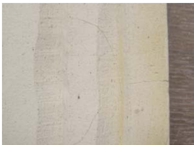
水分不適正で乾燥切れが起きた例
